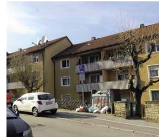
Zustand vor Rückbau
