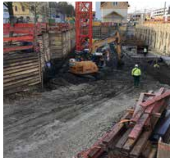
Blick in die Baugrube
