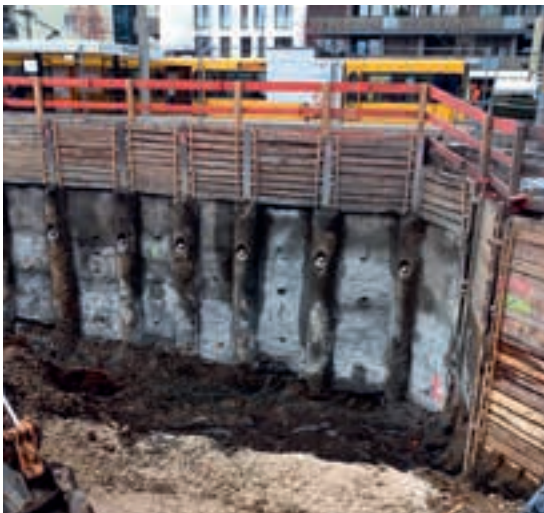
Verbaumaßnahme am Bahnsteig
