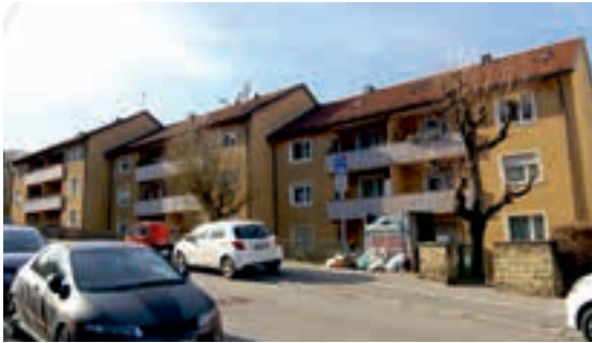
Zustand vor Rückbau
