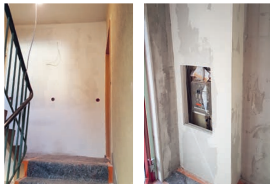
Sanierung der Treppenhäuser in der Schöttlestraße
