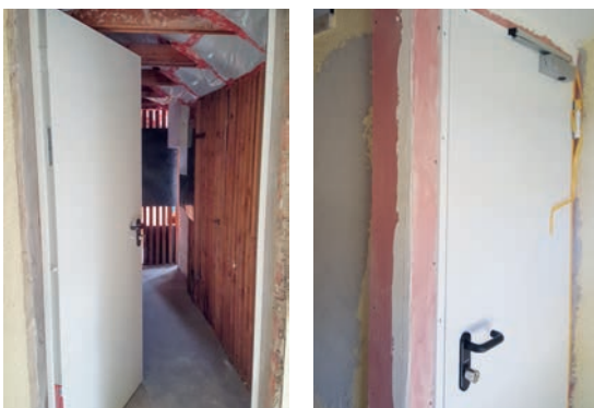
Sanierung der Treppenhäuser in der Eulerstraße
