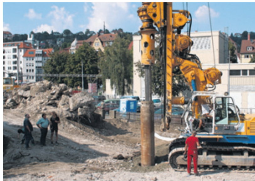
Am Vogelsang bei der Bauernmarkthalle wird fleißig gebaut: Die Friede-nau baut hier 44 Mietwohnungen neu. Aus statischen Gründen wird das gesamte Bauwerk auf 137 Betonpfählen errichtet. Foto: Günther
