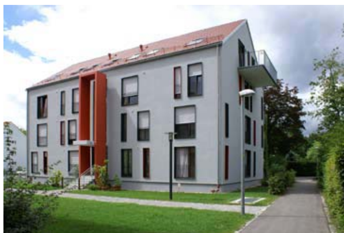
Ansicht Eulerstraße 43 in Stuttgart Dürrlewang (links) und Straßensicht Vogelsangstraße 114 in Stuttgart-West
